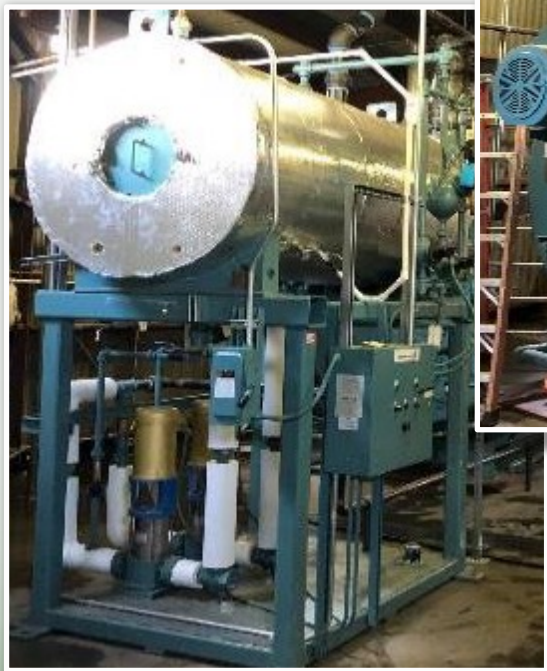
Tanque de alimentación de agua con capacidad de 500 galones
